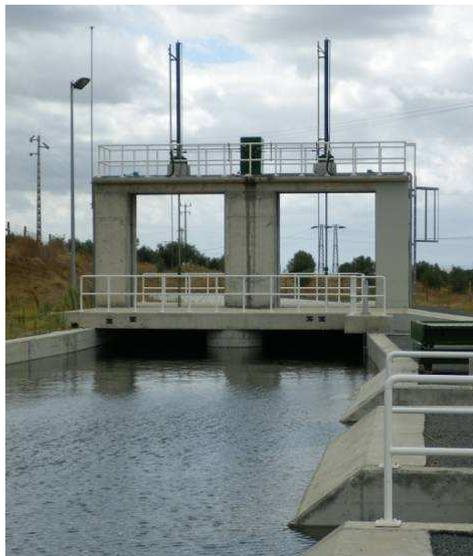
Figura 4 – Estrutura de regulação do canal Pisão-Roxo.
